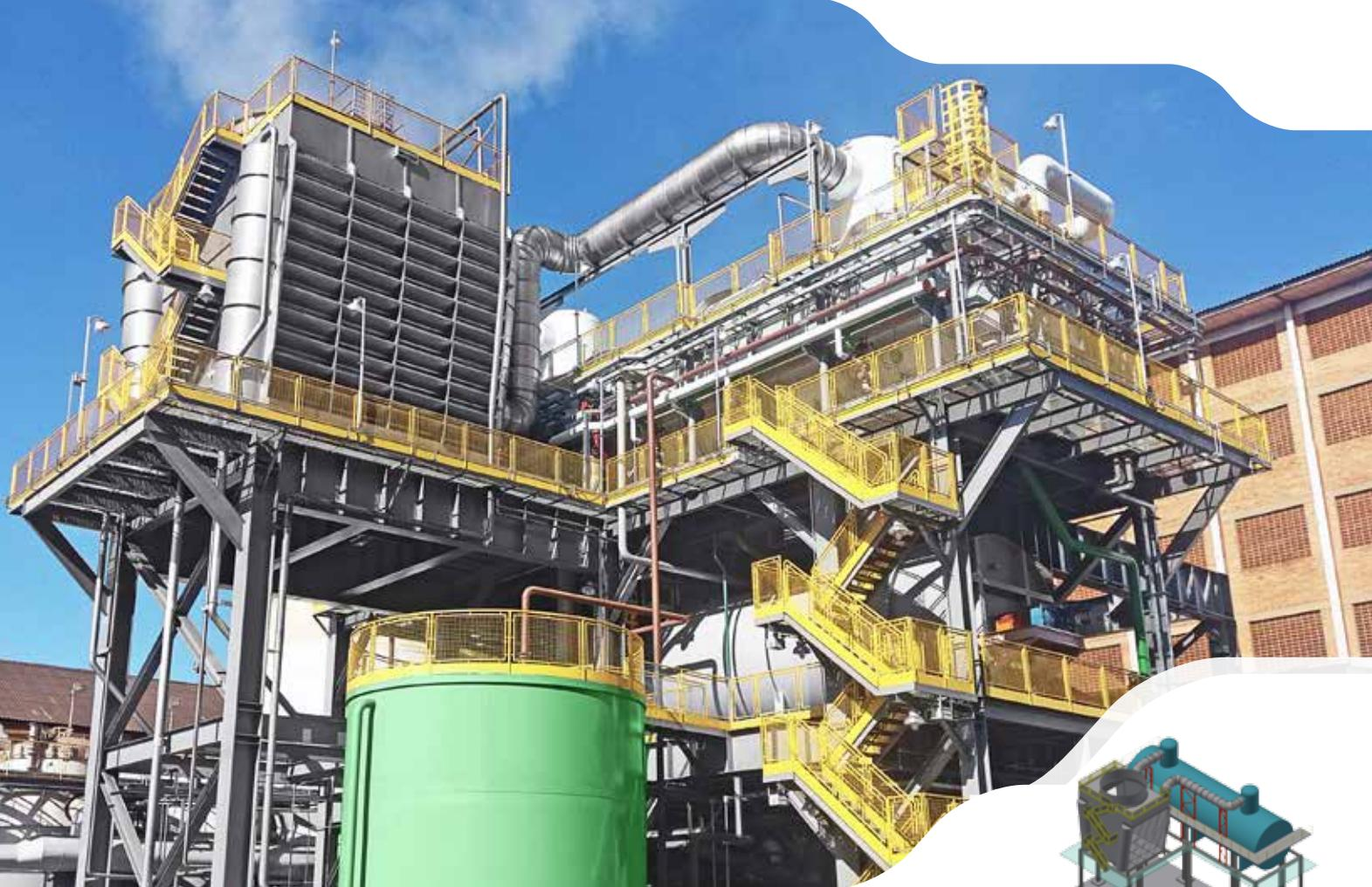
Condensador Evaporativo instalado em Cozedor Contínuo com capacidade de 2.800 HL
